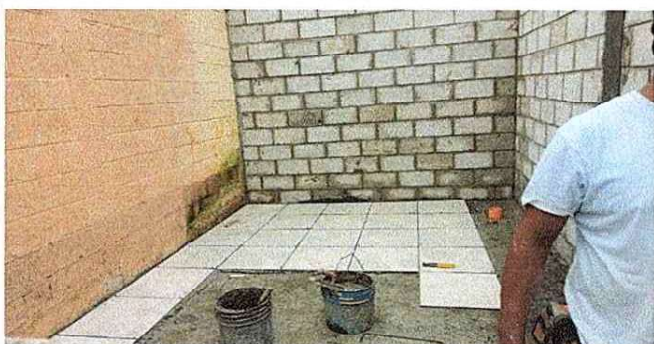
Foto 3: SUSTITUCION DE ISO CONCRETO POR PISO CERAMICA
