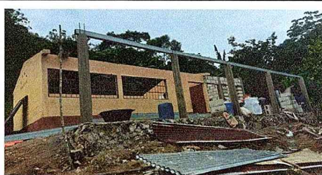
Foto 2: MANTENIMIENTO DE CORREDOR DE CONCRETO A PISO
