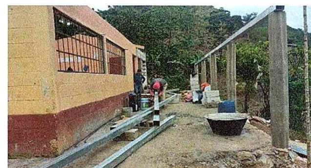
Foto 4: INSTALACION DE COSTANERAS DE METAL
